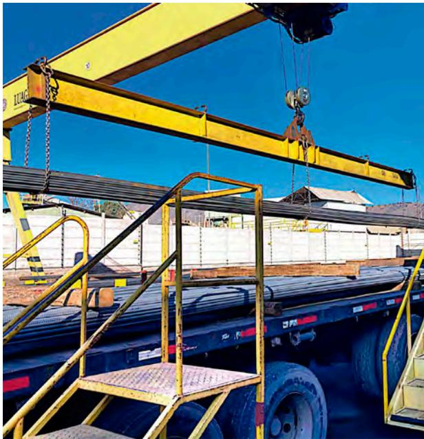
Figura 1.3.2.2: Carga o descarga del acero desde un camión mediante grúa.
