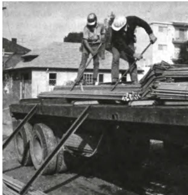
Figura 1.3.2.1: Descarga manual del acero desde camión.
