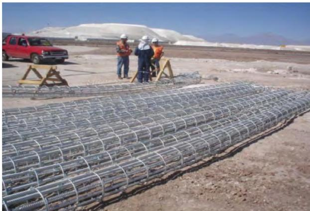
Figura 6.5.2.1: Armaduras galvanizadas de pilotes en salar de Atacama.
