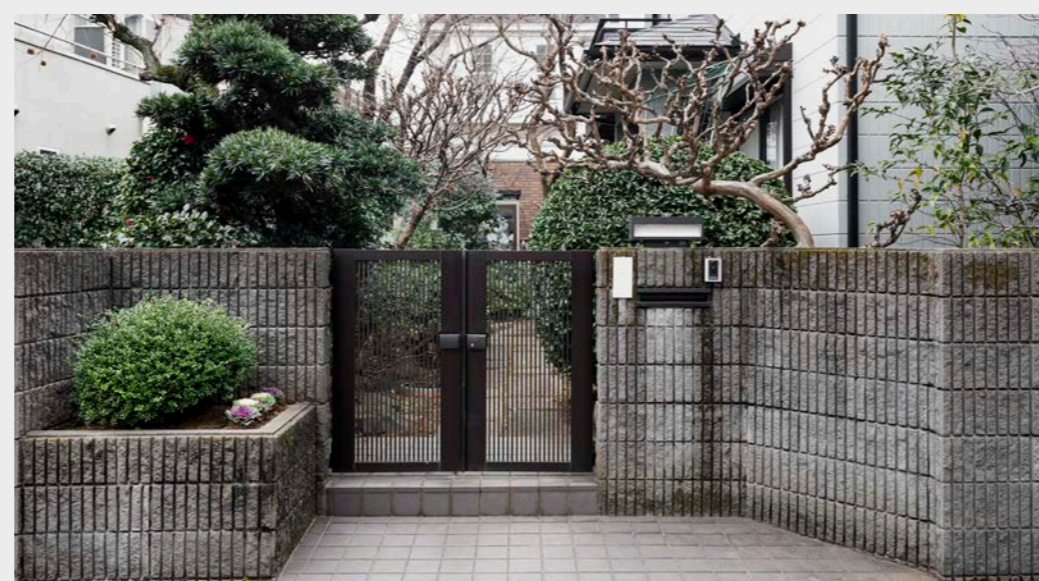
➔ Portón de entrada edificio
