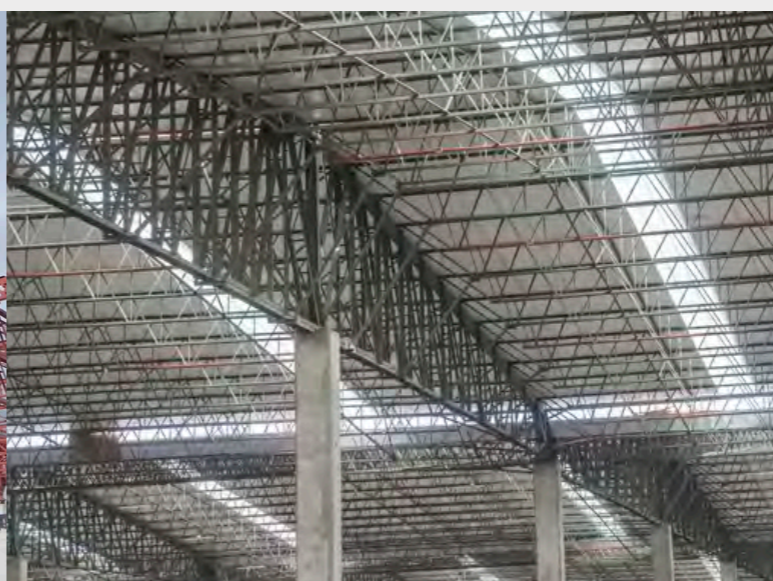
➔ Centro de Bodegas y Oficinas Los Boldos, Valle Grande
