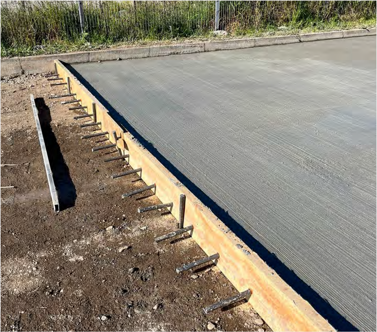
Barras de Traspaso de Cargas en junta de construcción
