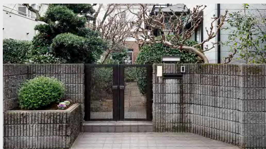
➞ Portón de entrada edificio
