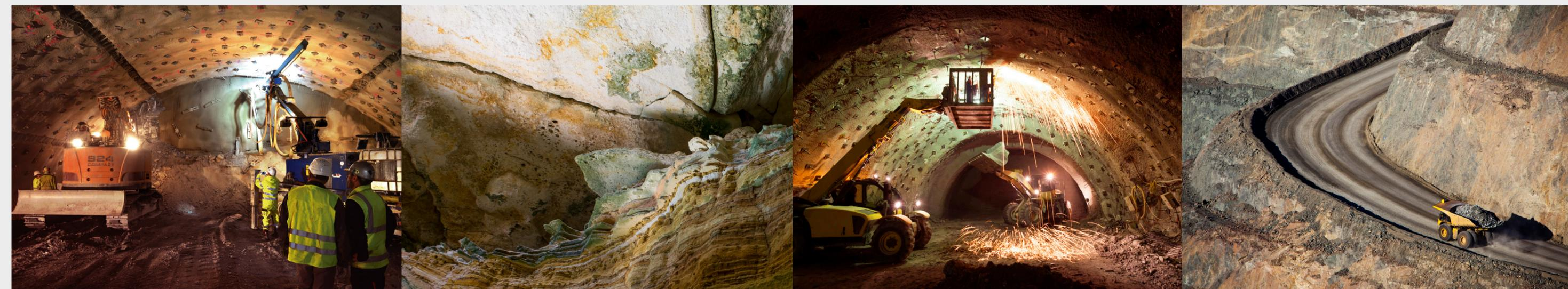
➔ Fijan cualquier roca suelta o estrato delgado en la superficie de la cavidad, anclándolos profundamente.
